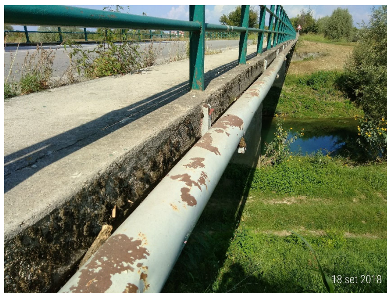
Fig. 3.3 Attraversamento aereo su Ponte Monticano: veduta verso nord della condotta esistente in acciaio DN100 mm
