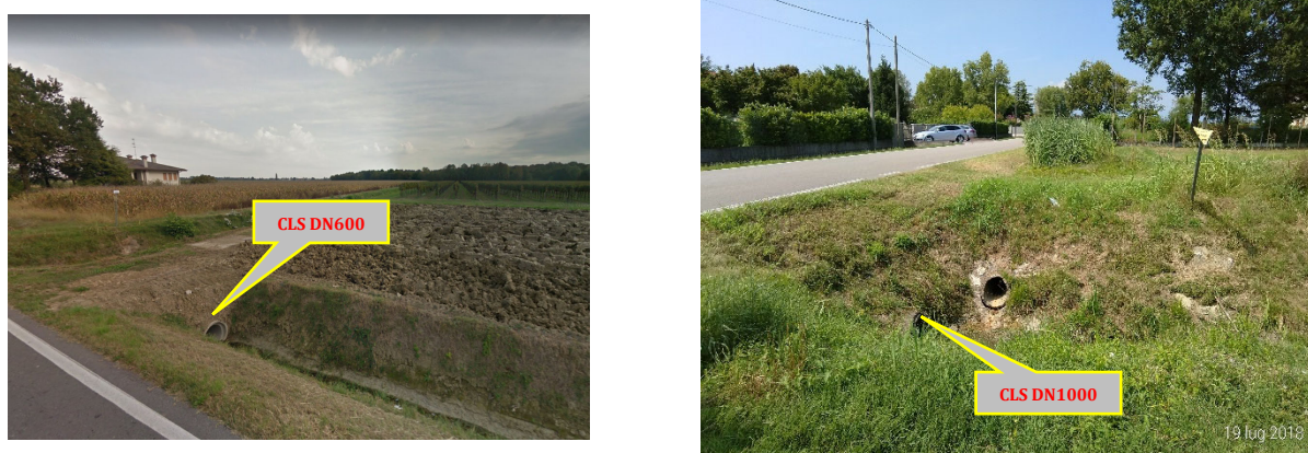
Fig. 3.5 Tombinamenti lato campagna (sinistra) e in attraversamento a Via Risorgimento (destra)
